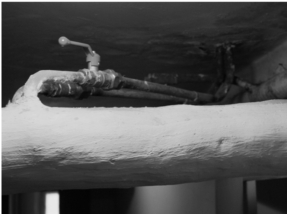
Zdjęcie 5. Budynek stary Rurociągi c.o. w izolacji trzcinowo-klejowej Skorodowane podejście pod pion bez izolacji
