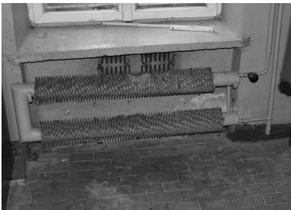
Zdjęcie 6. Budynek stary – pomieszczenie piwniczne Grzejniki z rur ożebrowanych Faviera Nawietrzaki okienne
