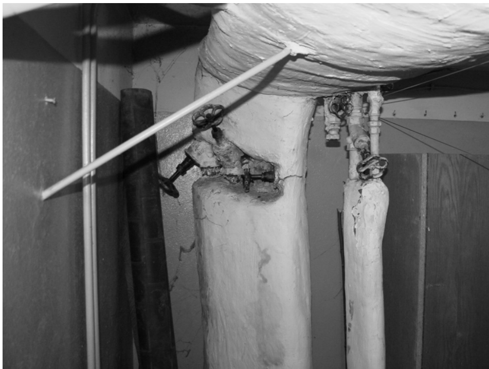
Zdjęcie 7. Budynek stary Skorodowane zawory na wejściu do kanału łączącego budynki Uszkodzona izolacja trzcinowo-gipsowa
