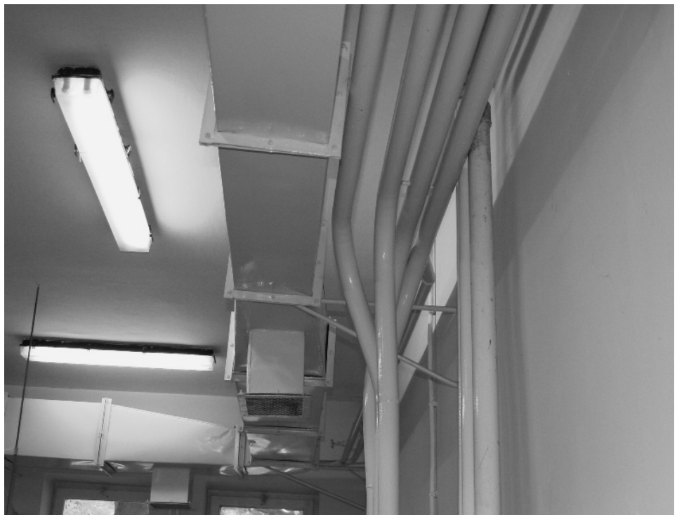
Zdjęcie 2. Budynek nowy – pomieszczenie kuchni Rurociągi głównego rozprowadzenia instalacji budynku nowego
